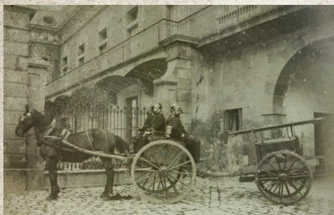
Armó d'artilleria amb bomba manual d'incendis (vehicle lleuger)
